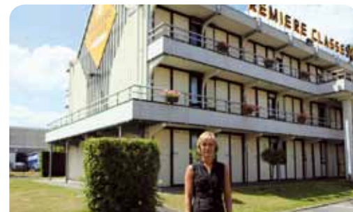
L'hôtel Première Classe vient d'être entièrement rénové : habillage extérieur relooké, chambres entièrement refaites... Emilie Le Chat est ravie.
